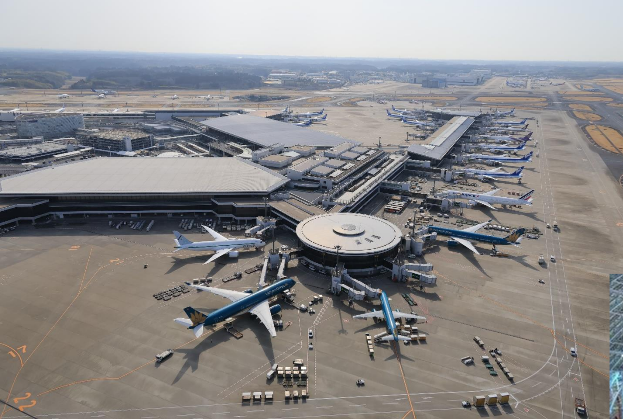
Aéroport international de Tokyo
